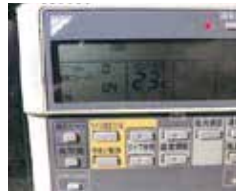
エラーコード：U4表示 基盤損傷
