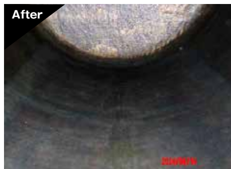
FRP内面ライニング施工後、消防検査時に指摘される事が無くなった。
