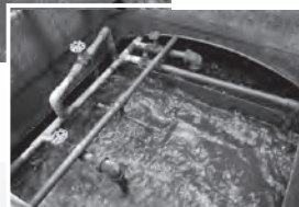
浄化槽及び排水管状況
